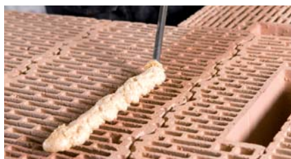
Technologie na zdicí pěnu Porotherm Dryfix
