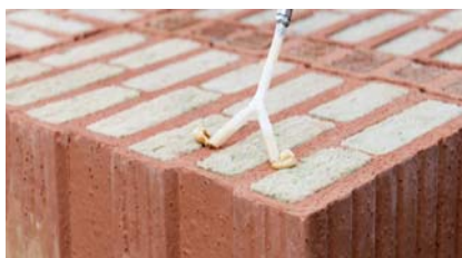
Technologie na lepidlo pro zdění Porotherm Dryfix.extra
